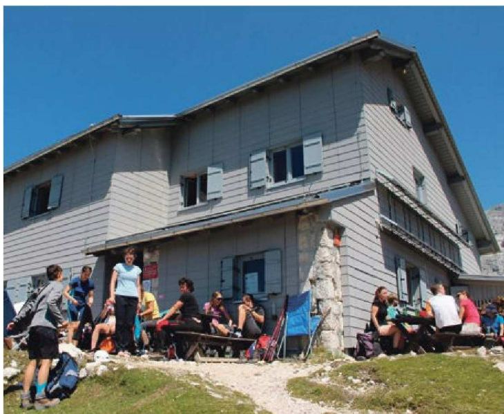
Julija so v Pogačnikovem domu na novo vzpostavili sistem samooskrbe z električno energijo. FOTO MANCA OGRIN
